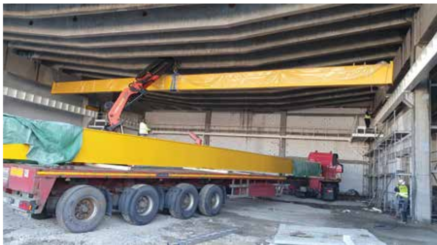
Obr. 1 - Instalace dvounosníkového mostního jeřábu v prostorách Škoda Auto, a.s.
