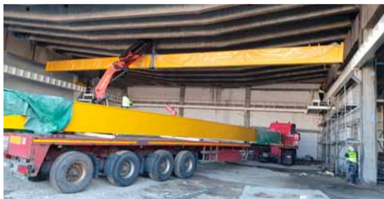
Obr. 1: Montáž dvounosíkového mostového jeřábu pro ŠKODA AUTO
